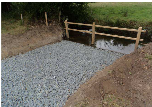
Descente au cours d'eau empierrée source : SABV
