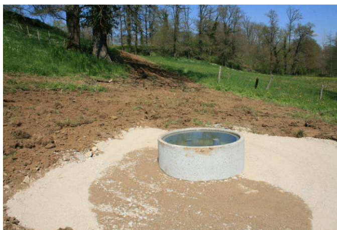
Buse - abreuvoir béton diamètre 1000 mm, hauteur 600 mm source : SABV
