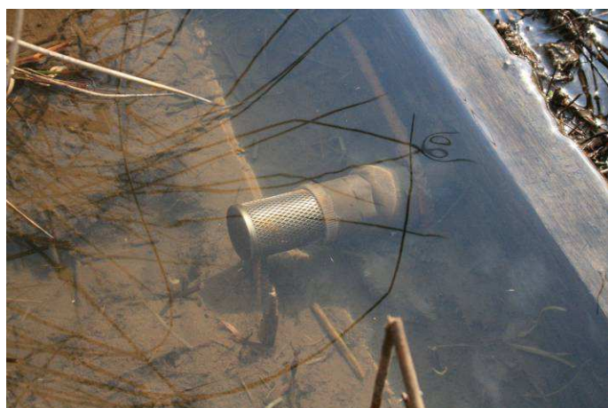
Prise d'eau simple : seuil en bois h< 30 cm et crépine Source : SABV
